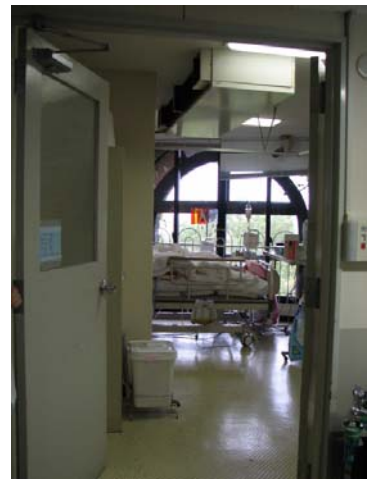
＜改修前の病室の様子＞
