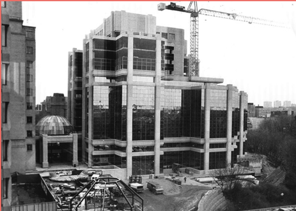
建設中の様子
