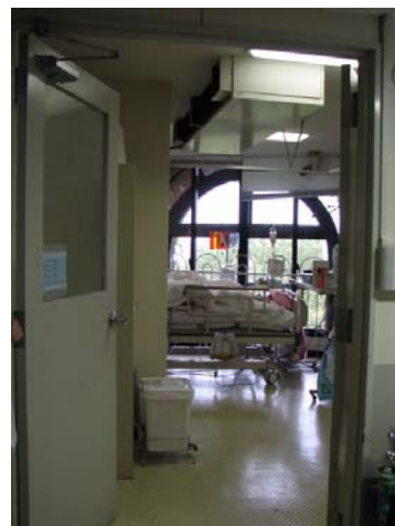
＜改修前の病室の様子＞
